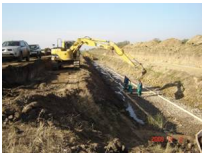
Makó III. csatorna burkolás
