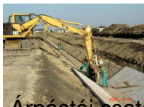
Arpástói csatorna burkolás
