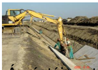
Árpástói csatorna burkolás
